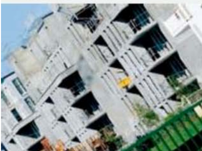
...réaliser la rénovation thermique : les démarches éco-responsables sont nombreuses.
